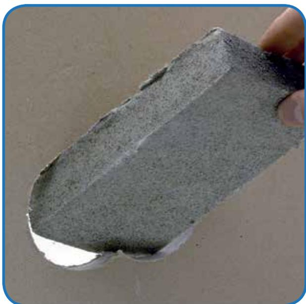
2b) Inserire F-BOX nel foro realizzato per l'inserimento della 253CG
