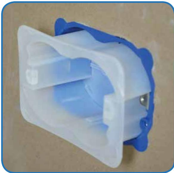
1) Dopo aver inserito il tubo corrugato nell'apposita prefincatura con sistema "Blocca Tubo" e i relativi cavi, effettuare l'inserimento della membrana nella scatola.
