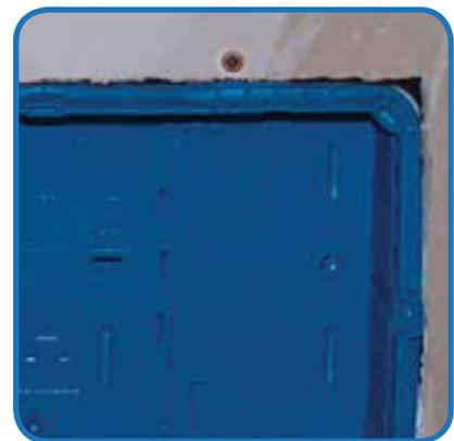
3) Inserimento vite fronte lastra nelle apposite orecchie di fissaggio
